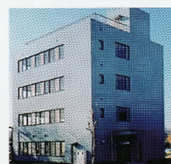
●本社ビル外観
